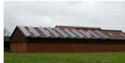
Aufgeständerte Solaranlage (> 20 cm)
