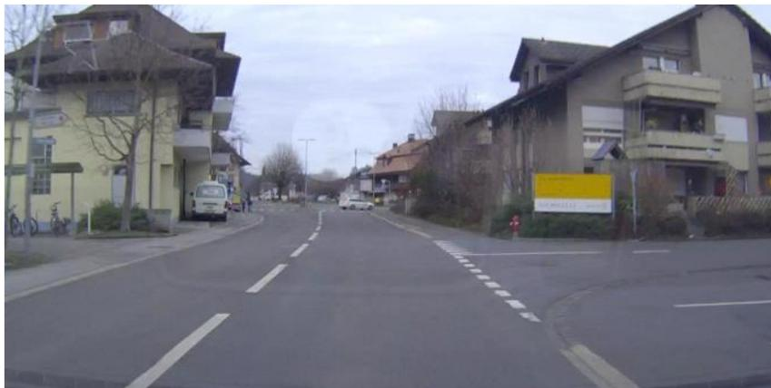
**Ausgangslage** Zufahrt zum Arbeitsgebiet Ey für Schwerverkehr ungenügend (Schleppkurven) und ab Blumensteinstrasse nur mittels Betriebswegweiser (SSV 4.49) signalisiert. Fehlende Führung FV auf Sägeweg. Unzweckmässige Zufahrt Industriegebiet durch das Wohngebiet. Industriezone Ey ist gem. RGSK II TOW ein ländlicher Arbeitsschwerpunkt (Festsetzung), d.h. es ist die Ansiedlung weiterer Industrie- und Gewerbebetriebe zu erwarten.
