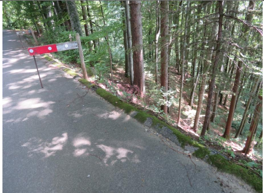
Foto 2: Dito Foto 2. Mit einem Teerwulst wird verhindert, dass Oberflächenwasser in den steilen Hangbereich gelangt.
