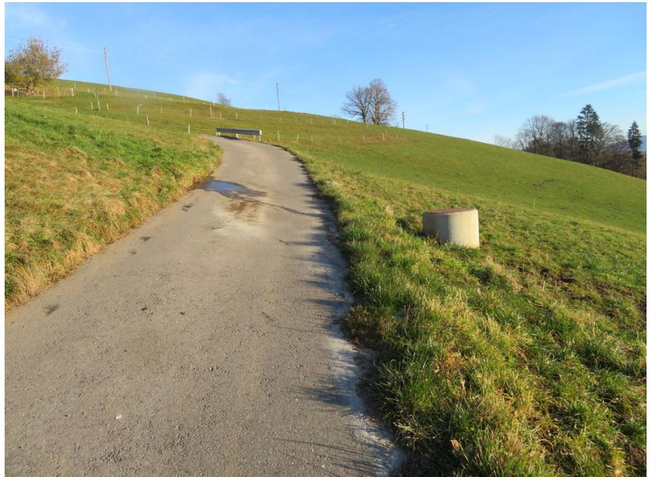
Foto 7: Hangbereich bei Steimatt: ersichtlich sind Vernässungen und eine Wasserfassung.
