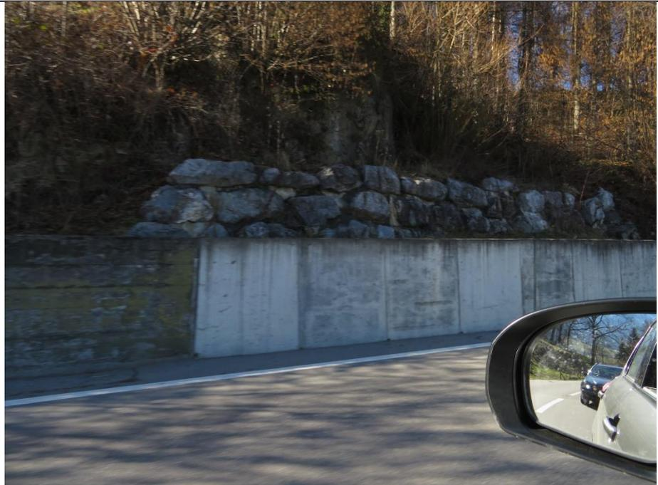
Foto 6: Stützmauer mit aufliegendem Blocksatz in einer Runse nordöstlich des Prozessgebietes.
