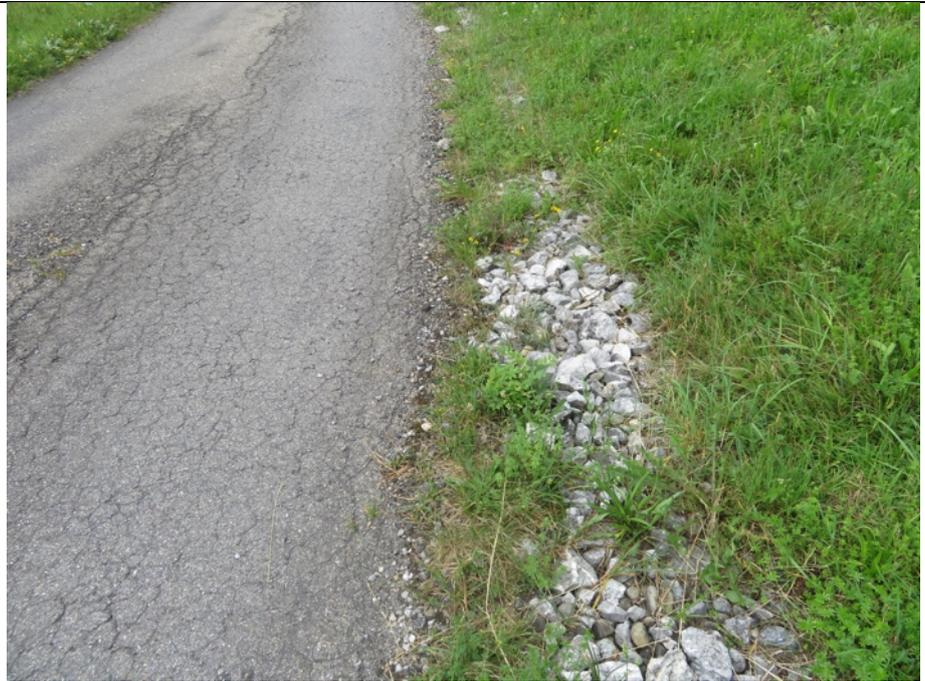
Foto 3: Drainage entlang der Strasse weist auf Wasservorkommen im Hang hin.
