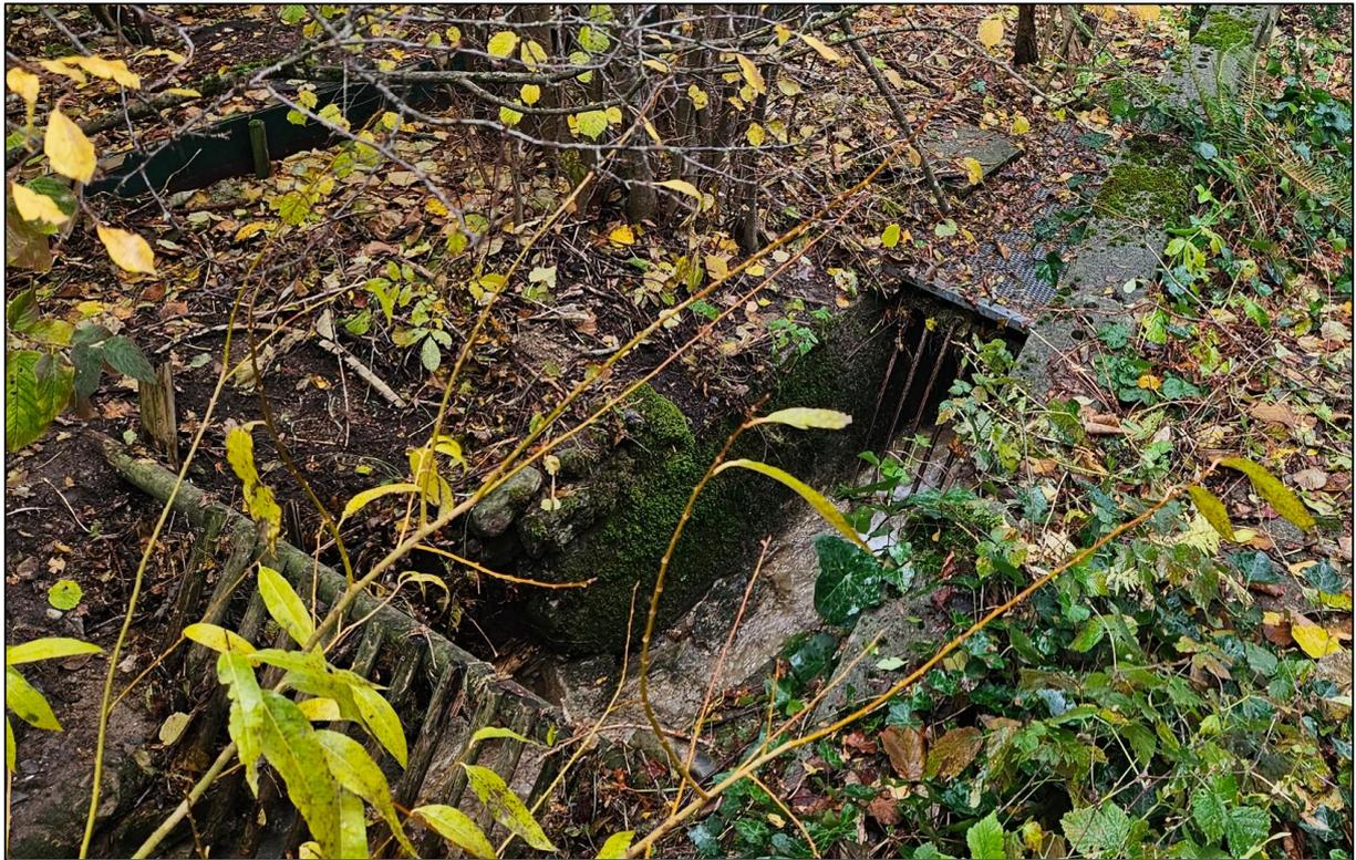
**Abb. 9 EINLAUFBEREICH DER MITTLEREN EINDOLUNG, MIT STAHLRECHEN UND VORGELAGERTEM HOLZRECHEN**
