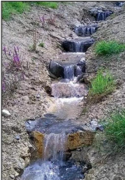
**Abb. 18 BEISPIELBILD EINER SPERRENTREPPE MIT NIEDERWASSERBEREICH**
