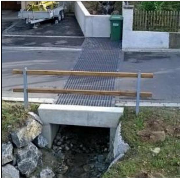
Abb. 22 BEISPIEL ÜBERFAHRT MIT GITTERROSTABDECKUNG
