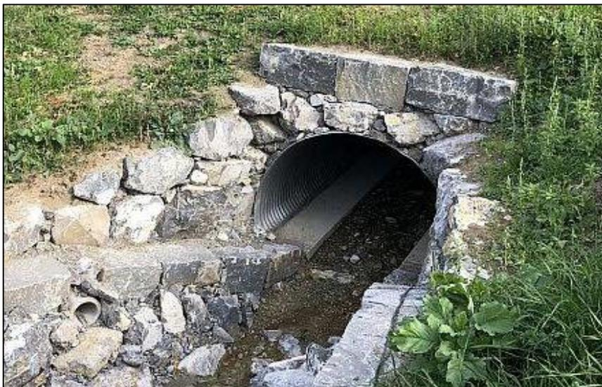
Abb. 21 BEISPIEL EINES BACHDURCHLASSES MIT SPIREL-ROHR (QUELLE: SYTEC.CH)
