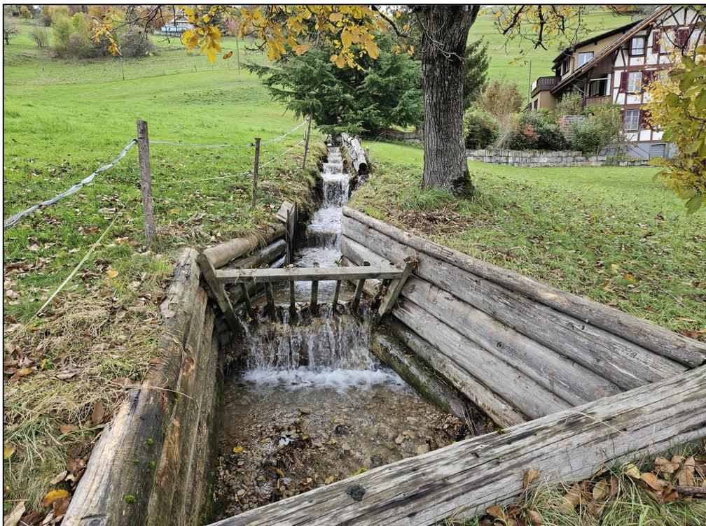
**Abb. 4 EINLAUFBAUWERK BEI KANTONSSTRASSE, MIT HOLZVERBAU. BLICK GEGEN FLIESSRICHTUNG.**
