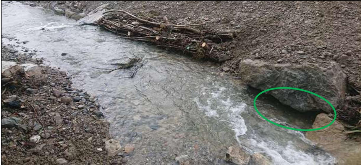
**Abb. 13** BESPIELE FÜR UNTERSTÄNDE AUS BLOCKSTEINEN UND VERBAU MIT FASCHINEN
