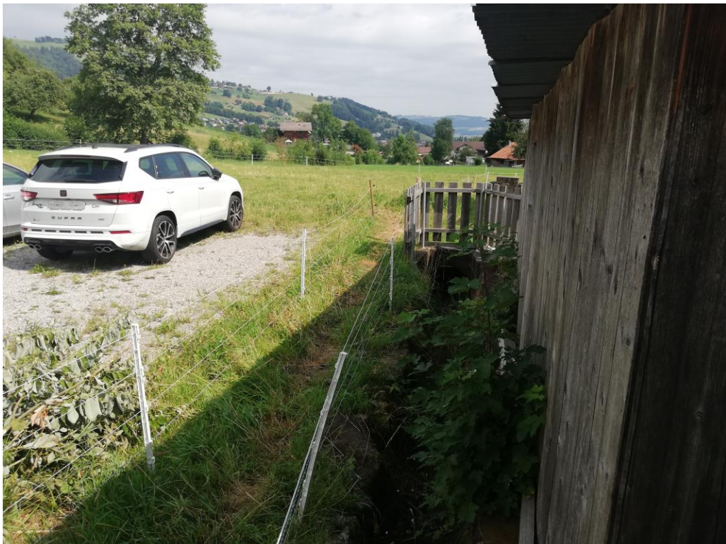
Abbildung 34: Bestehender Bachlauf, Einlaufbauwerk bei Gebäude 10, Blickrichtung bachabwärts, 17.7.2023
