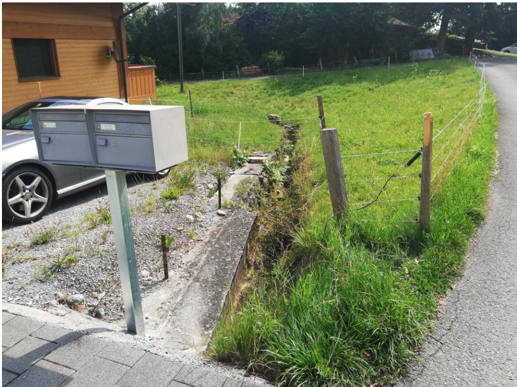
Abbildung 30: Bestehender Bachlauf unterhalb Durchlass Mettleneggenstrasse, Blickrichtung bachabwärts, 17.7.2023
