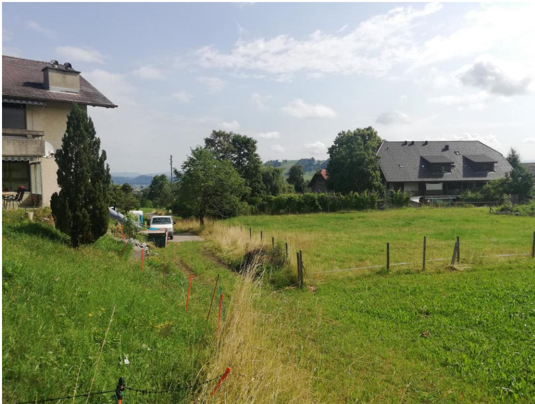
Abbildung 17: Eindolung Schyberainweg, Blickrichtung bachabwärts, 17.7.2023
