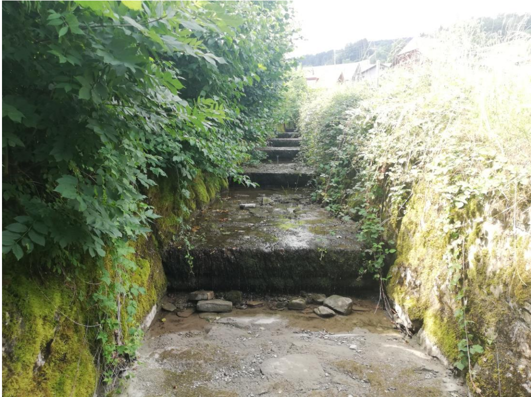
Abbildung 37: Spengelibach im Bereich des Anschlusses des neuen Bachlaufs, Blickrichtung bachaufwärts 17.7.2023
