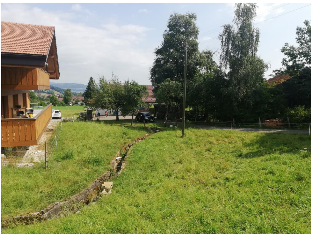
Abbildung 32: Bestehender Bachlauf bei Gebäude 12, Blickrichtung bachabwärts, 17.7.2023
