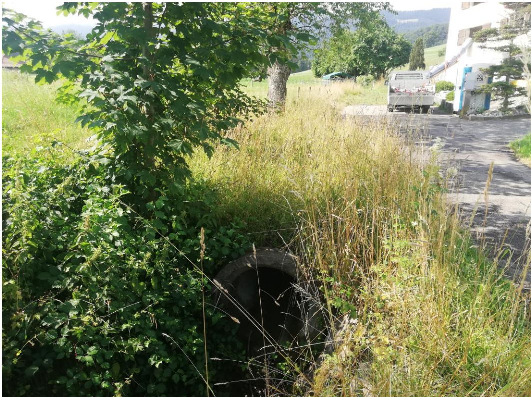
Abbildung 22: Wiese mit Obstbäumen, Auslauf Eindolung Blickrichtung bachaufwärts, 17.7.2023
