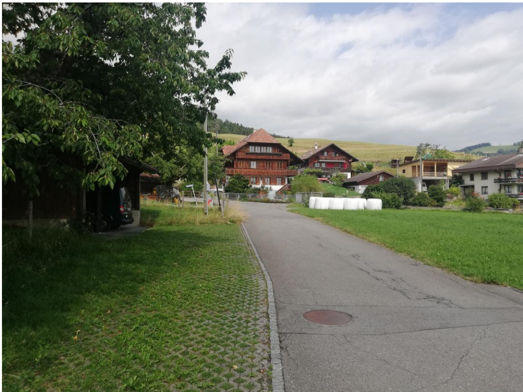
Abbildung 28: Mettleneggenstrasse, Blick von bestehendem Durchlass in Richtung Lage des neuen Durchlasses, 17.7.2023
